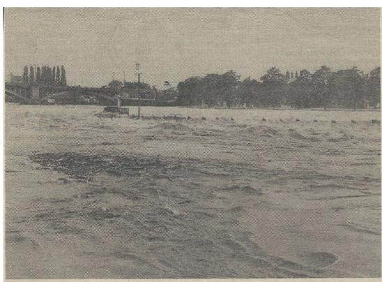
Submergé par les eaux tumultueuses de la Meuse en crue, et hors d'usage, le pont-barrage de Visé constituait depuis lundi à la fois un obstacle au déferlement naturel des eaux et un danger de nouvelles inondations en amont du fleuve. Aussi une unité du Génie a-t-elle procédé, dans la nuit de lundi au dynamitage de l'ouvrage afin de faire baisser les eaux et d'épargner ainsi une nouvelle invasion liquide de cette région touristique.
